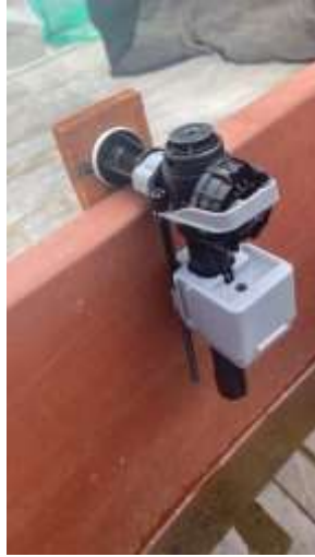
Figura 4. Control del nivel de agua de los peces empleando un flotador comercial.
