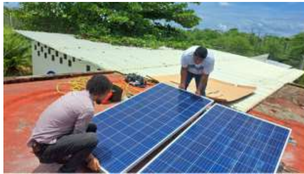
Figura 2. Instalación e inclinación requerida de los paneles solares.
