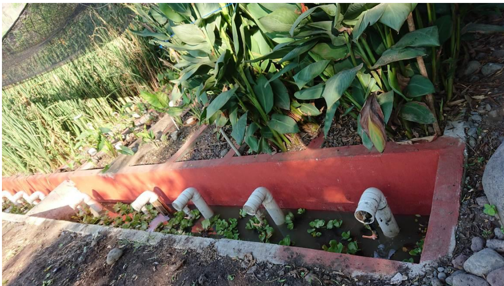
Figura 1. Ecotecnología de humedal construido en la localidad de Pastorías, Actopan, Veracruz, México.
